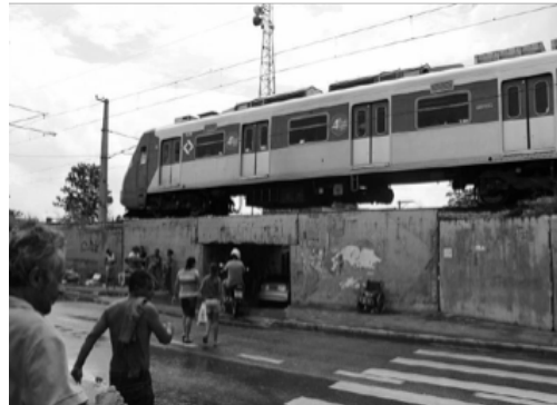
Figura 2: Vista de um dos acessos à área de várzea, por baixo da linha férrea, antes das obras executadas pela CPTM. Fonte: Antonucci e Gobbi, 2016. 10
