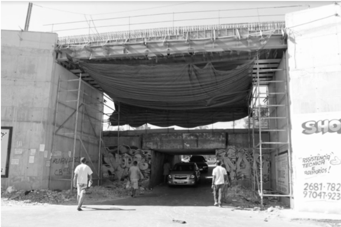
Figura 5: Em primeiro plano, vista da nova cota da linha férrea e do novo acesso. Ao fundo, antigo acesso que permitia a passagem de um automóvel por vez. Fonte: foto cedida por Leonardo Gobbi, 2016. 10
